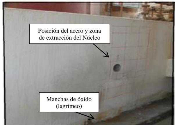
Figura 5. Zona de extracción de la muestra 2 (Exterior)
