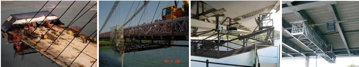
Figura 7. Izquierda: pasarelas provisionales de obra para acceso bajo el tablero del Viaducto C. Fernández Casado (cortesía del Ing. D. Pablo Díaz Simal) y del Puente colgante de Amposta. Derecha: Pasarelas de inspección y mantenimiento de los Puentes de Rande y Waterford.
