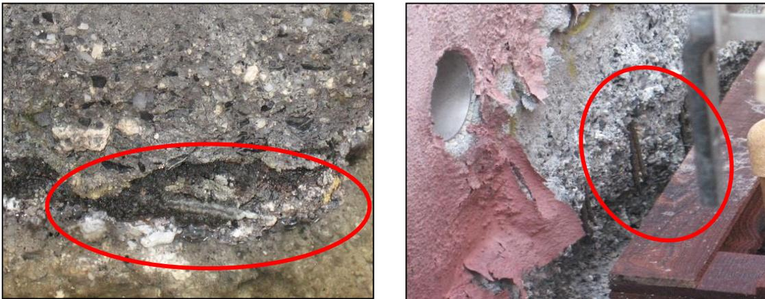
Figura 7. Pérdida de sección y rotura del acero de refuerzo en base de los muros de contención
