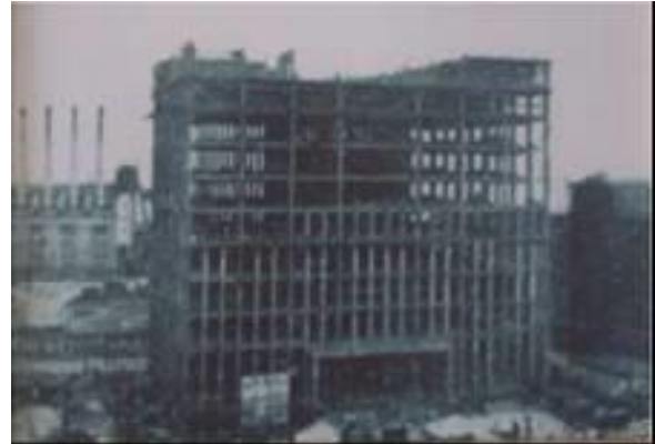
Foto da construção
