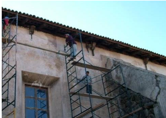
Figura 11. Colocación de andamios para la restauración de los botareles
