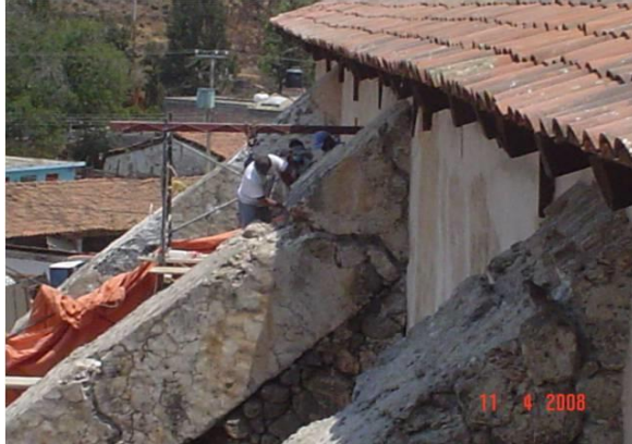
Figura 10. Contrafuertes fracturados.
