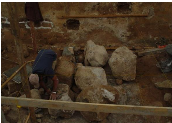
Figura 12. Cimentación de contrafuerte.
