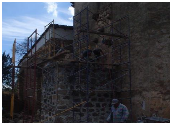
13. Proceso de restauración de los contrafuertes
