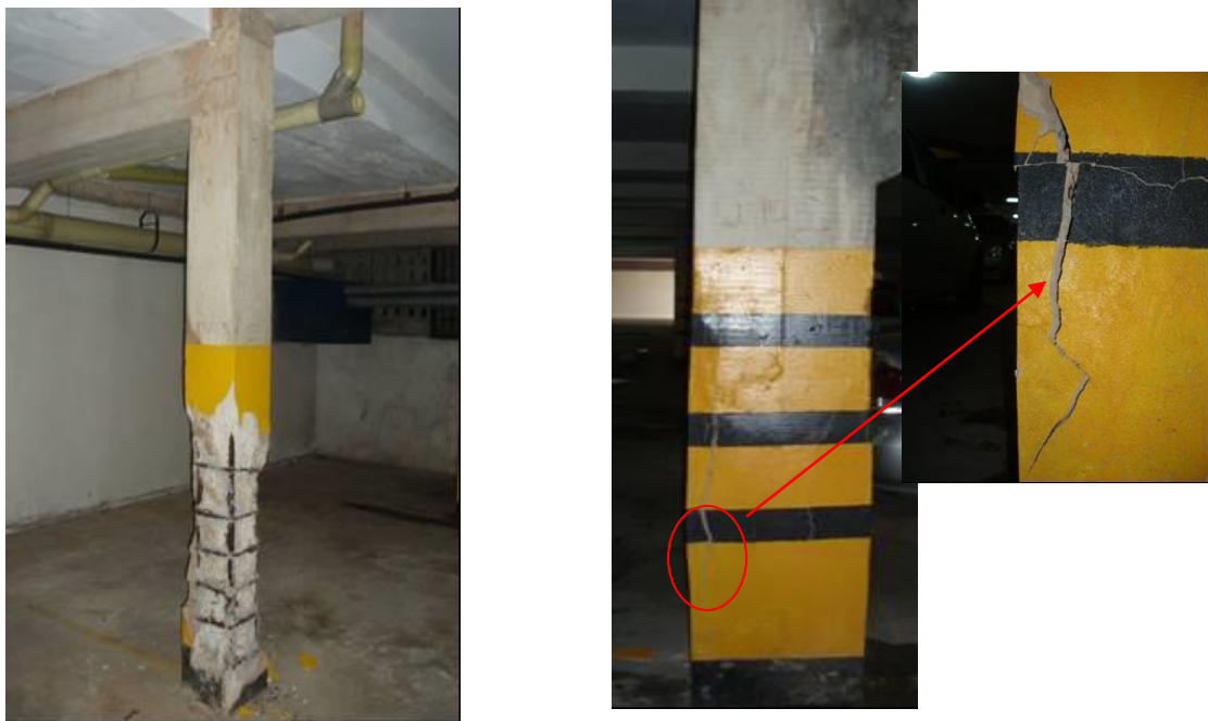
Figura. 2. Levantamiento fotográfico detallado de algunas Columnas con daños severos por corrosión de la armadura (a) Delaminación con acero expuesto en casi toda el área de las caras sur y este por debajo de 120 cm. (b) Cara Oeste. Detalle. Grieta y concreto fofo por debajo de 120 cm.
