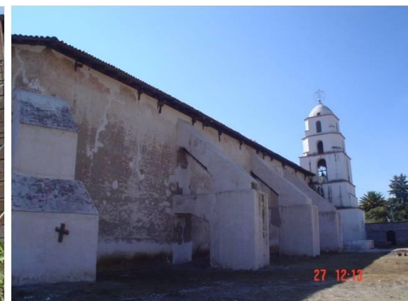
Figura 15. Contrafuertes restaurados
