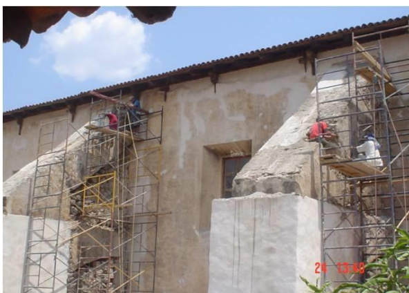
Figura 14. Restauración de botareles.
