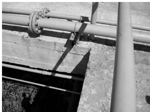
Figura 5. Viga 1k fisura transversal
