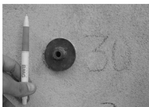
Figura 2. Pastilha metálica colada no revestimento.
