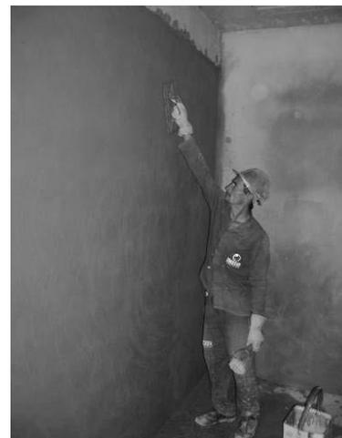
Figura 10. Desempenamento do emboço para o acabamento.
