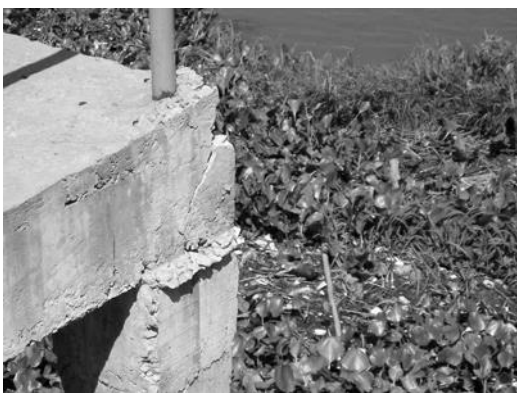
Figura 4. Viga 18 fisurada
