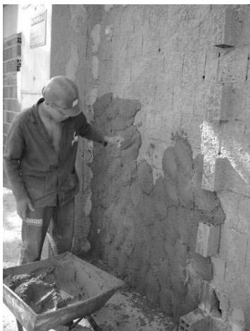
Figura 9. Aplicação manual da argamassa na parede.
