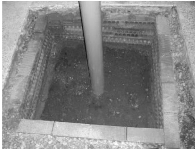
Figura13. Fotografía de la construcción de la arqueta situada bajo la solera de sótano
