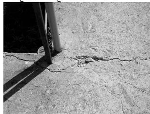
Figura 7. Losa 18 fisura transversal
