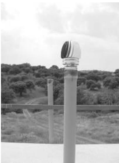
Figura 15. En esta fotografía se encuentra abierto el tiro de la arqueta situada bajo el módulo mientras que el otro tubo está sellado.
