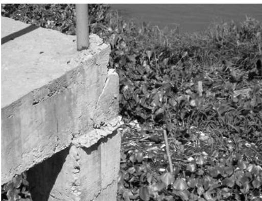
Figura 4. Viga 18 fisurada
