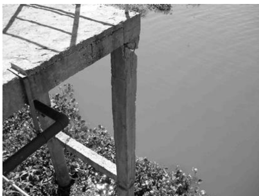
Figura 2. Pilar 25 impactado
