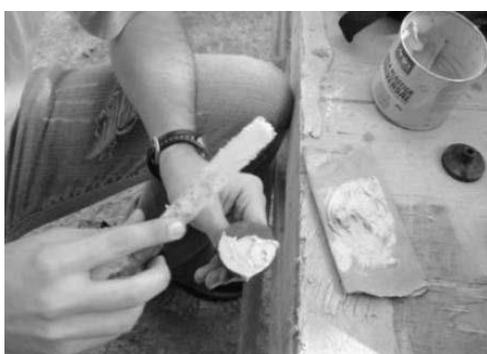
Figura 1. Aplicação da cola na pastilha para posteriormente fixar na parede
