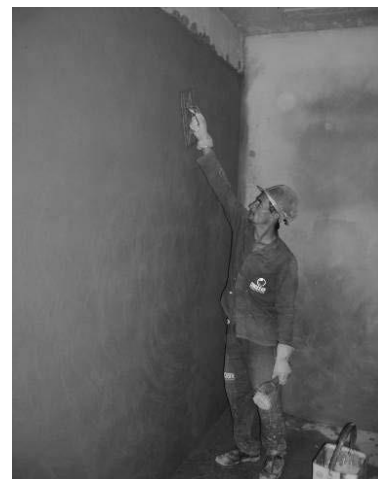
Figura 10. Desempenamento do emboço para o acabamento.
