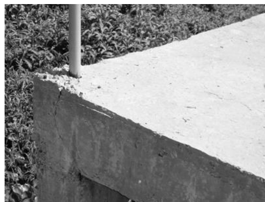
Figura 3. Viga 20 fisurada
