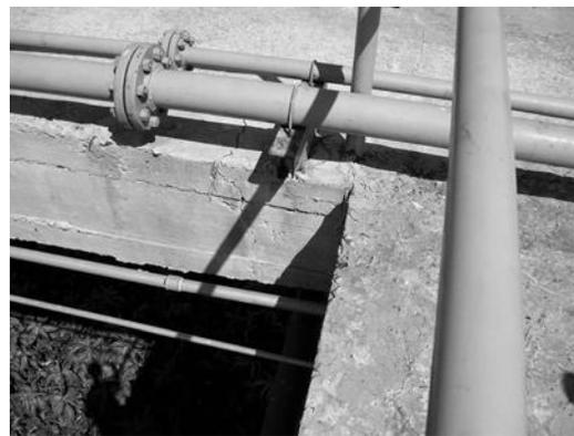
Figura 5. Viga 1k fisura transversal
