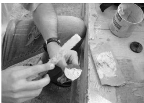
Figura 1. Aplicação da cola na pastilha para posteriormente fixar na parede
