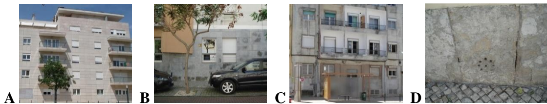
Figura 1. Condiciones de degradación de los revestimientos pétreos
