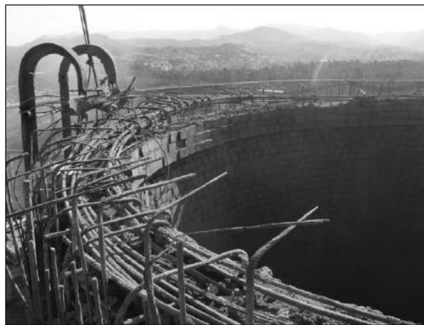
Figura 12. O concreto comprometido é demolido
