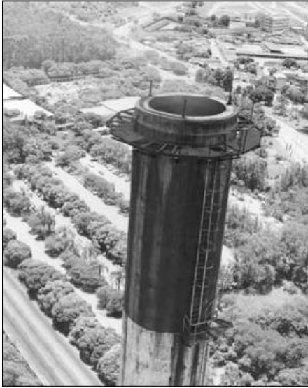
Figura 2. Foto aérea de um topo de chaminé obtida em vôo de helicóptero.
