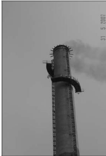
Figura 11. Construção da plataforma de serviço no topo da chaminé
