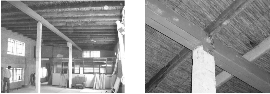
Figura 4. Columnas de hormigón armado de planta alta - Elementos de cubierta de planta alta
