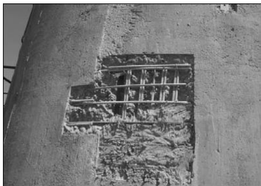
Figura 17. Preenchimento das cavidades rasa com argamassa polimérica
