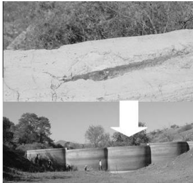
Figura 7. Desprendimiento del mortero de recubrimiento en la parte superior del arco.
