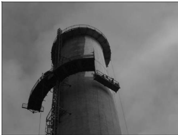
Figura 10. Equipamentos de acesso utilizados nos trabalhos de reparo.
