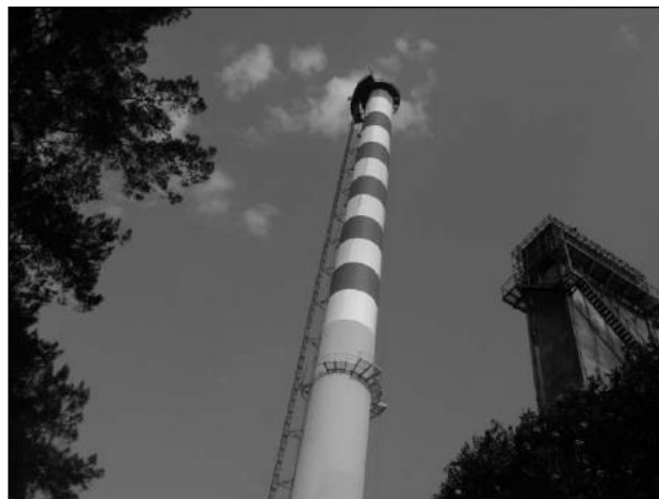
Figura 20. Aspecto final de uma chaminé recuperada
