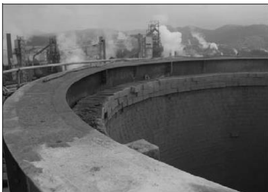
Figura 15. Reconstituição da parede com concreto aluminoso
