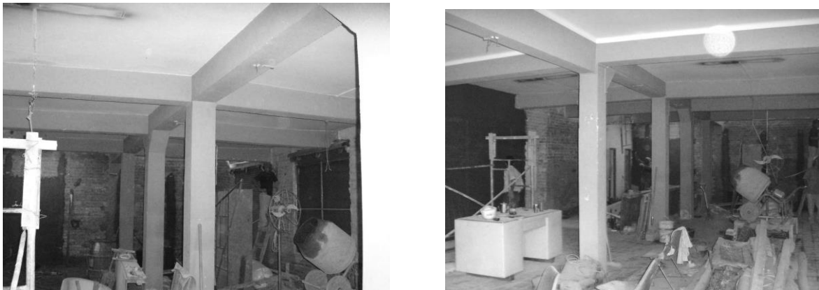
Figura 3. Losas, vigas y columnas de hormigón armado de planta baja
