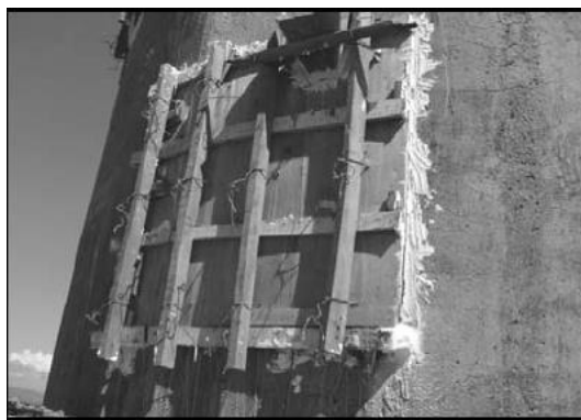
Figura 18. Preenchimento das cavidades profundas com graute de cimento
