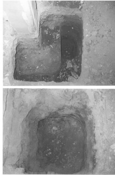
Figura 6. Fundación de columna
