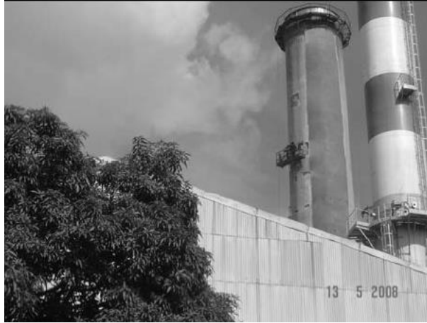
Figura 19. Aplicação de um revestimento polimérico elástico nas superfícies
