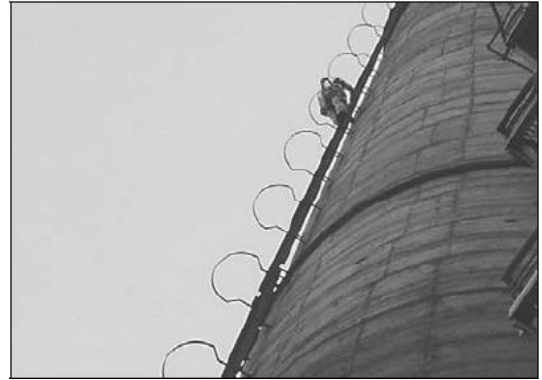
Figura 3. Inspeção por alpinista profissional
