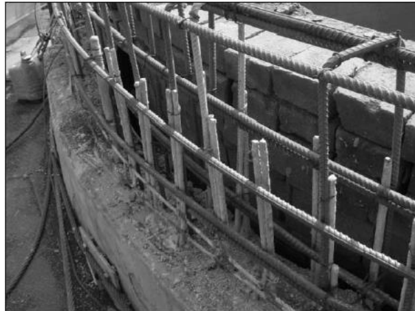
Figura 13. Os tijolos refratários são reposicionados, assim como as armaduras da parede
