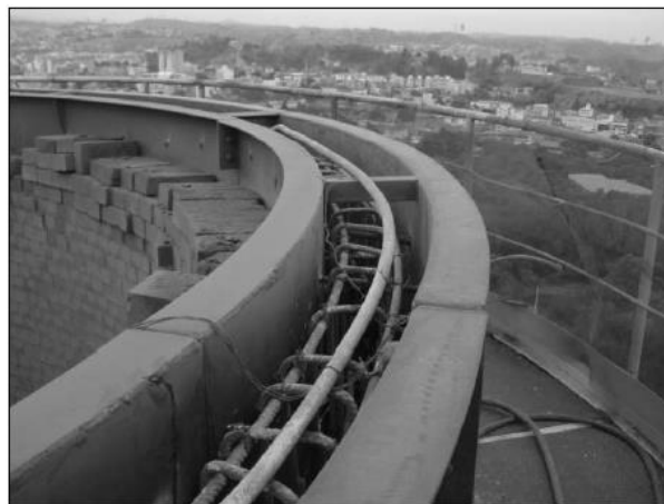
Figura 14. Instalação dos módulos das fôrmas internas e externas em aço inox.
