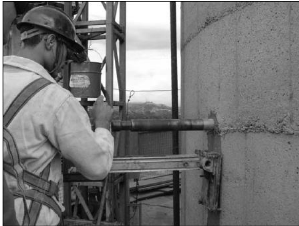
Figura 7. Extração de corpos de prova em uma junta de concretagem de uma chaminé
