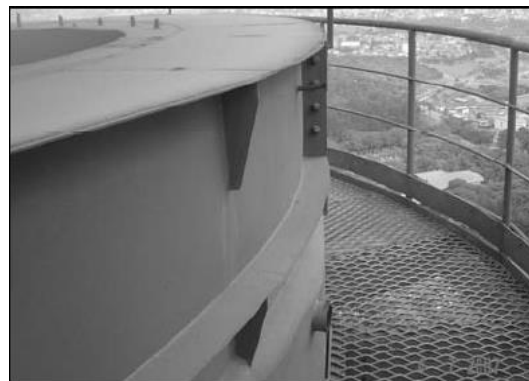
Figura 16. São instaladas chapas de proteção em inox do topo
