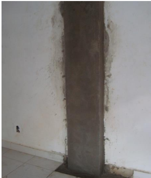
Figura 10. Aspecto final dos pilares reforçados.
