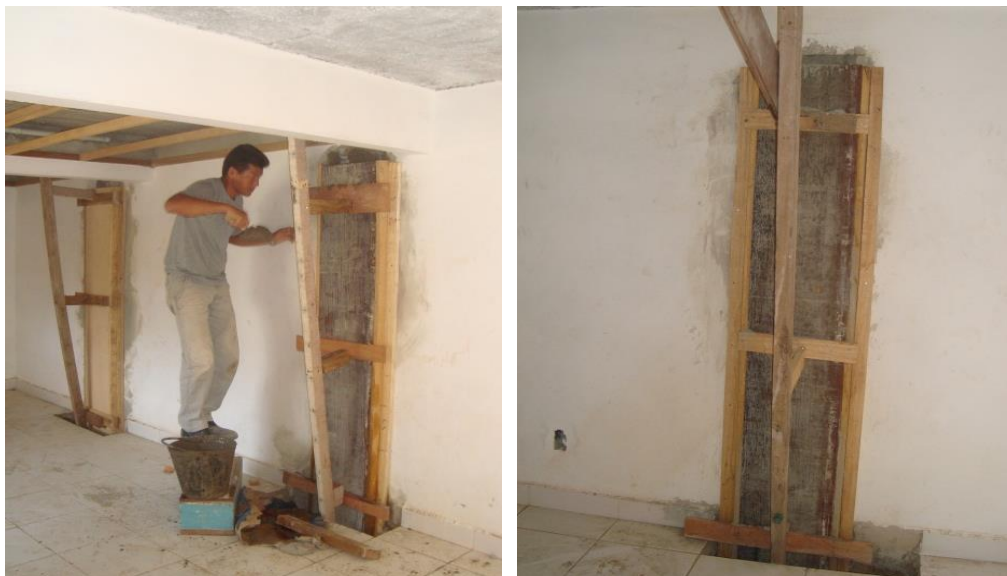
Figura 9. Concretagem do reforço dos pilares.
