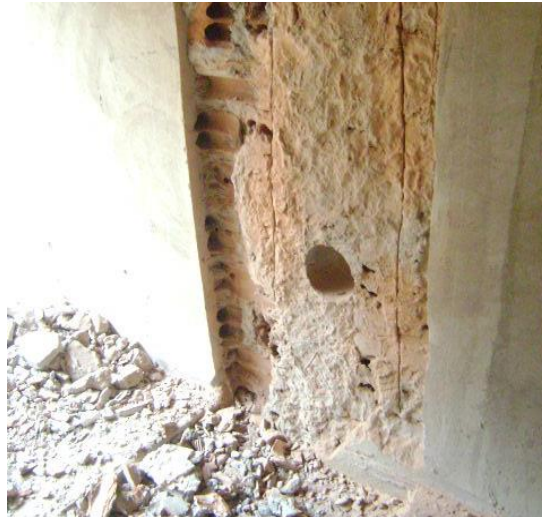
Figura 4. Local da extração de testemunho em um pilar.
