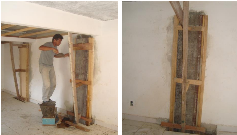
Figura 9. Vaciado del concreto de refuerzo de los pilares.
