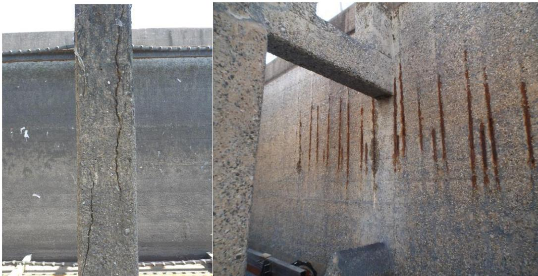
Figura 1. Columnas de concreto fisuradas, con reparaciones. Armaduras expuestas y corroídas.
