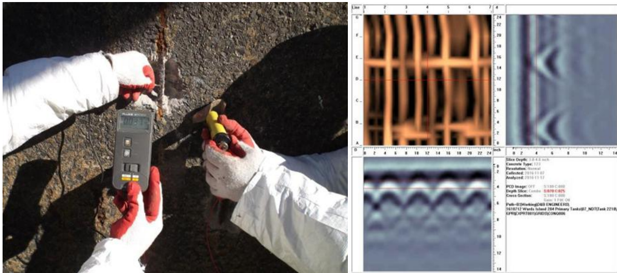
Figura 2. Ensaio de Meia-Célula: Medição de potenciais de corrosão. GPR: Identificação de falhas internas e localização de vergalhões.
