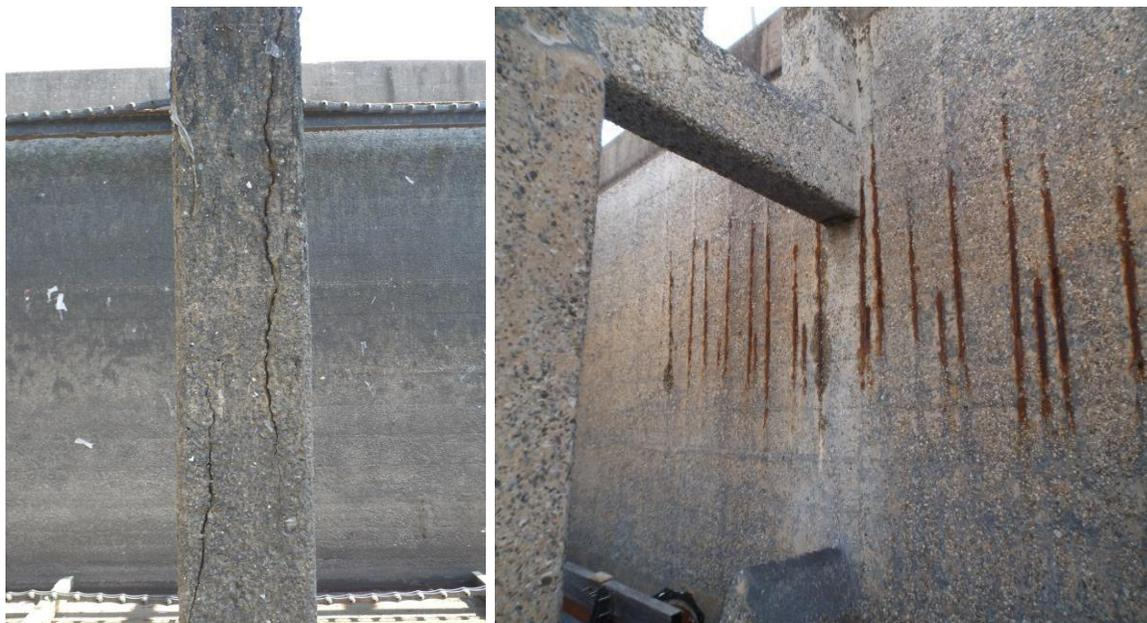
Figura 1. Colunas de concreto fissuradas, com deslocamentos e reparos. Armaduras expostas e corroídas.
