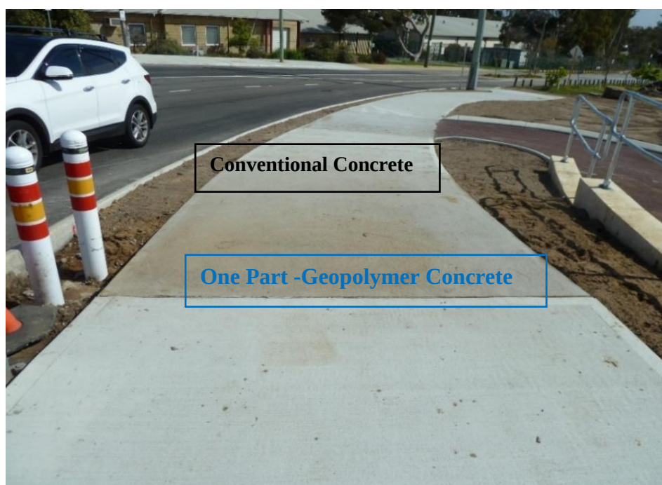
Figura 4. Calçada de concreto para pedestres
