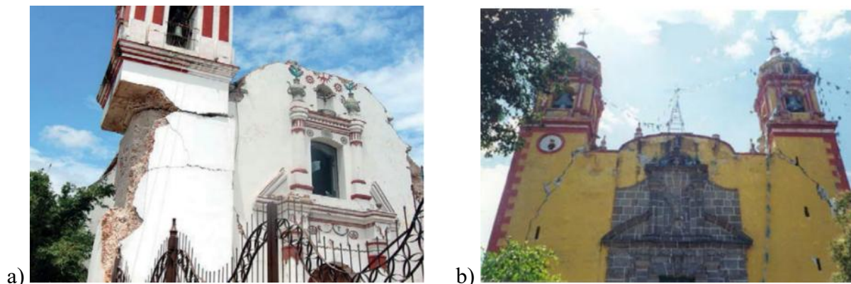
Fig. 1. Tendência de deterioração e falha em torres sineiras fixadas a corpos adjacentes; a) falha horizontal devido a terremoto com tendência a tombar no topo devido à mudança abrupta de volume. Imagem obtida do Ministério da Cultura, Governo do México. (2024), b) falha diagonal devido a um terremoto pela mudança abrupta de seção. Imagem retirada de: De la Torre RO, et. al. (2004).
