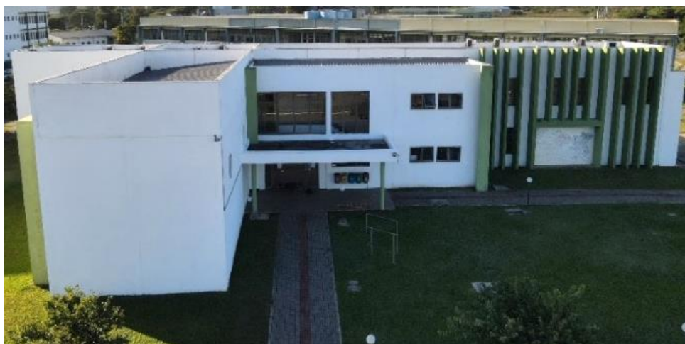
Figura 8. Aspecto de la fachada oeste posterior a 6 meses de revitalización
