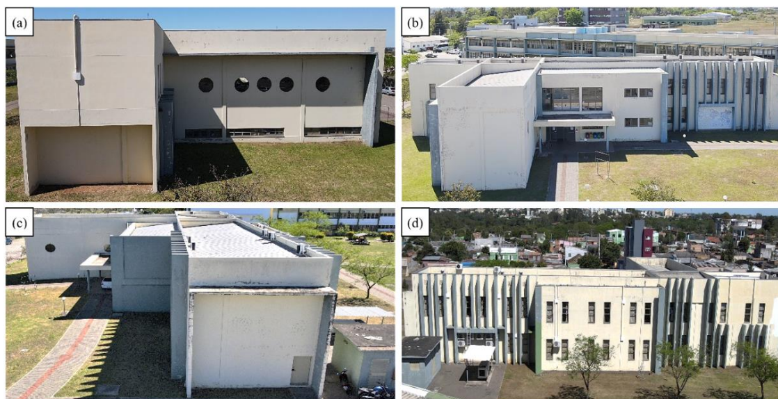
Figura 11. Fachada Norte (a), Fachada Oeste (b), Fachada Sur (c), Fachada este (e) antes de la revitalización.
