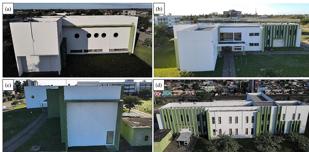
Figura 12. Fachada Norte (a), Fachada Oeste (b), Fachada Sur (c), Fachada Este (e) luego de la revitalización.
