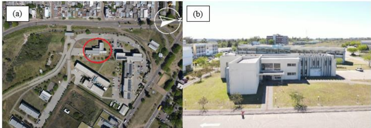
Figura 3. Edificio de estudios: a) Ubicación del edificio en el Campus de UNIPAMPA en Alegrete/RS; b) Fachada de acceso al edificio DTIC.
