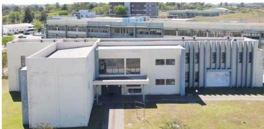
Figura 5. Fachada Oeste antes de la revitalización.
