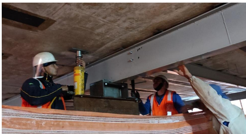
Figura 5. Operarios realizando el macaqueo de una de las vigas metálicas del refuerzo en el subsuelo.
