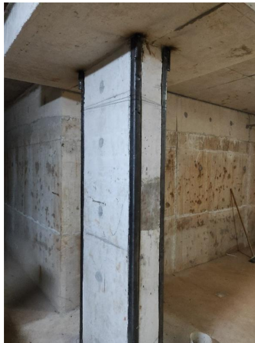
Figura 13. Ángulos de refuerzo adheridos en pilar rectangular.
