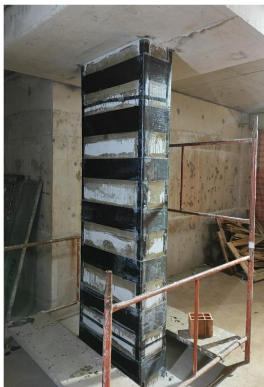
Figura 14. Mantas de fibra de carbono adheridas, confinando pilar rectangular.
