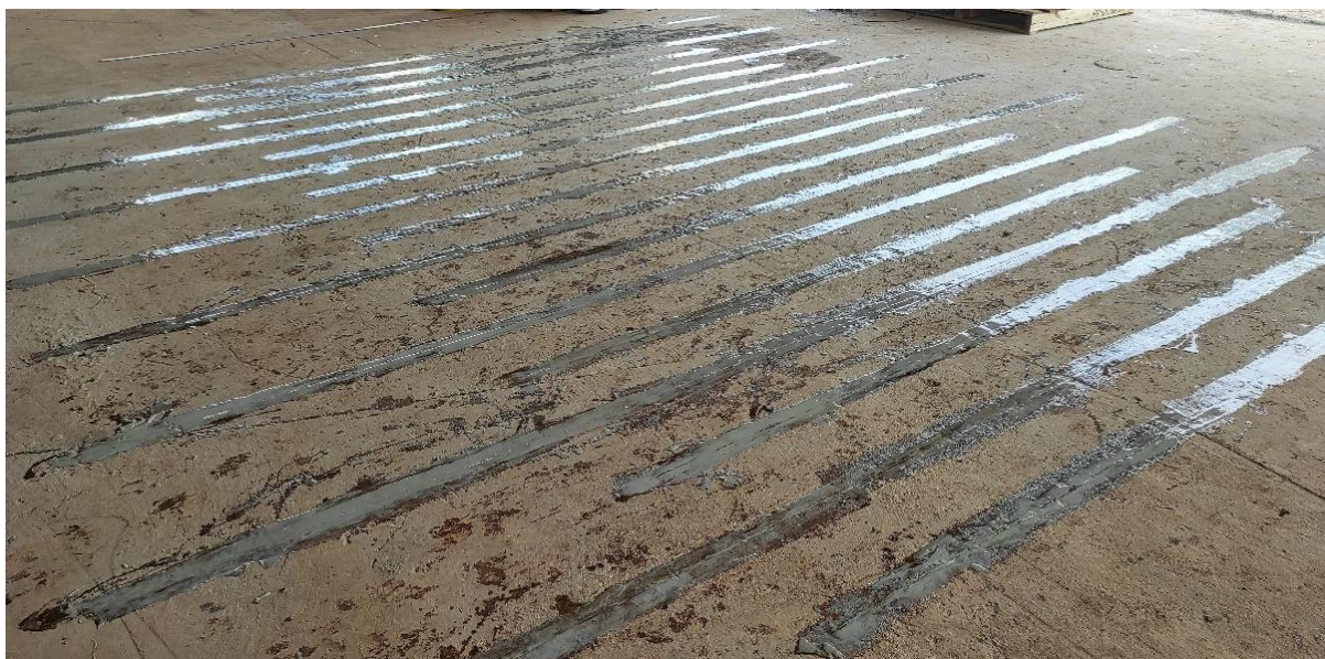
Figura 11. Ejemplo de aplicación de la fibra de carbono insertada ( cut in ).
