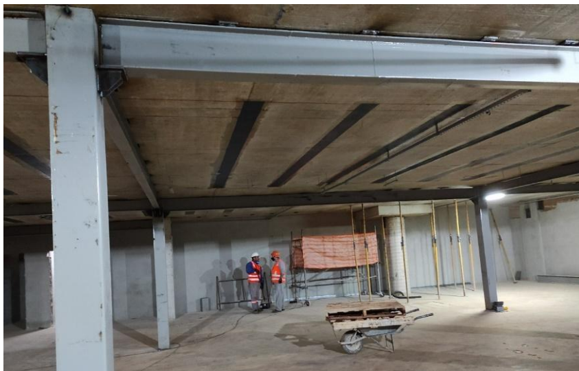
Figura 4. Pilares y vigas metálicas del refuerzo en el subsuelo.
