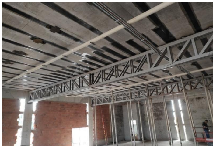
Figura 7. Cerchas metálicas en la región del auditorio (losa del piso del segundo nivel).
