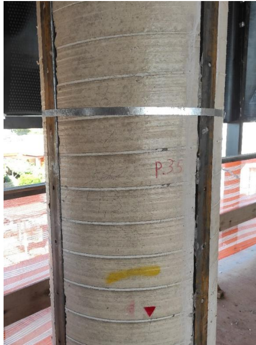
Figura 12. Refuerzo de pilar circular con perfiles metálicos.
