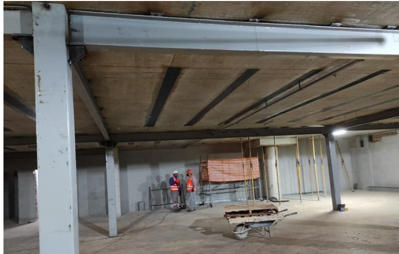
Figura 4. Pilares e vigas metálicas do reforço no subsolo.
