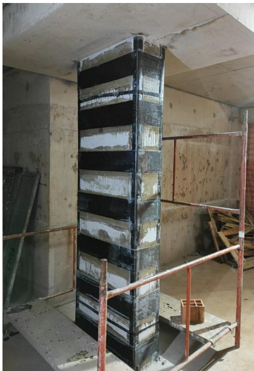
Figura 14. Mantas de fibra de carbono coladas cintando pilar retangular.
