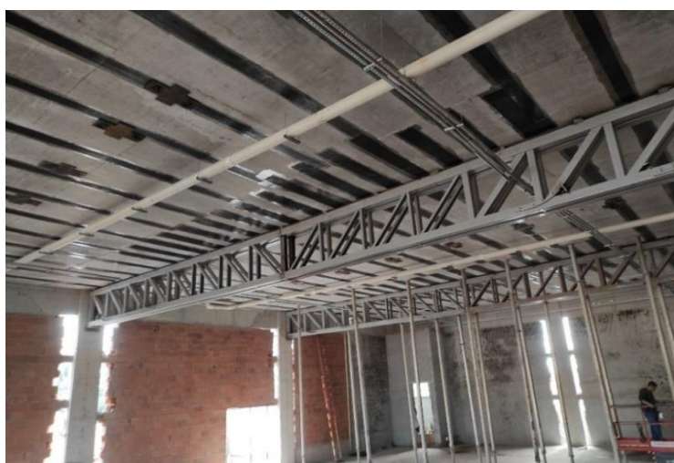
Figura 7. Treliças metálicas na região do auditório (laje do piso do 2º pavimento).
