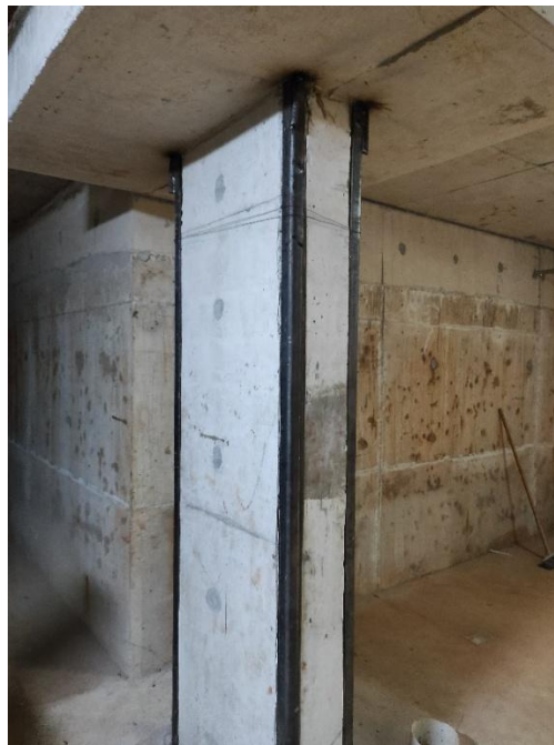
Figura 13. Cantoneiras de reforço coladas em pilar retangular.
