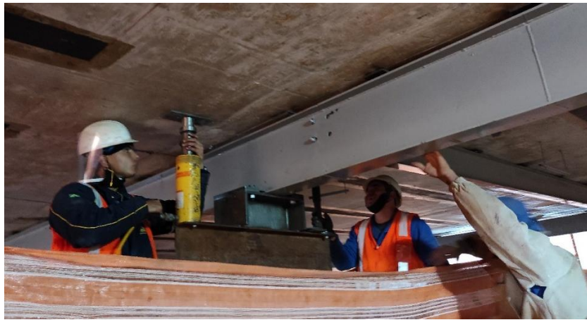
Figura 5. Operários realizando o macaqueamento de uma das vigas metálicas do reforço no subsolo.
