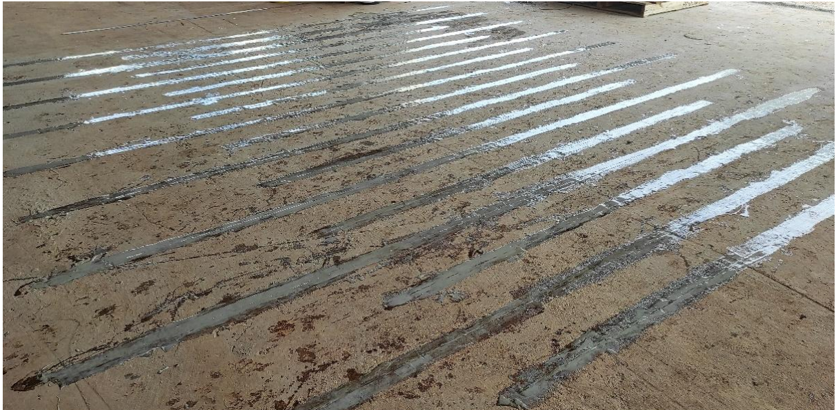
Figura 11. Exemplo de aplicação da fibra de carbono inserida ( cut in ).
