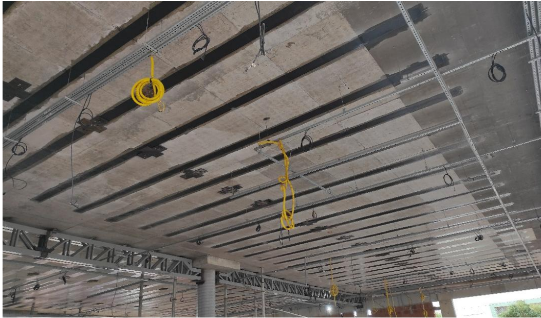
Figura 10. Mantas de fibra de carbono aplicadas na laje do 2º pavimento.
