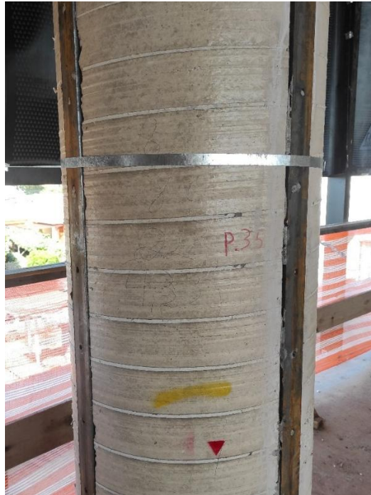
Figura 12. Reforço de pilar circular com perfis metálicos.
