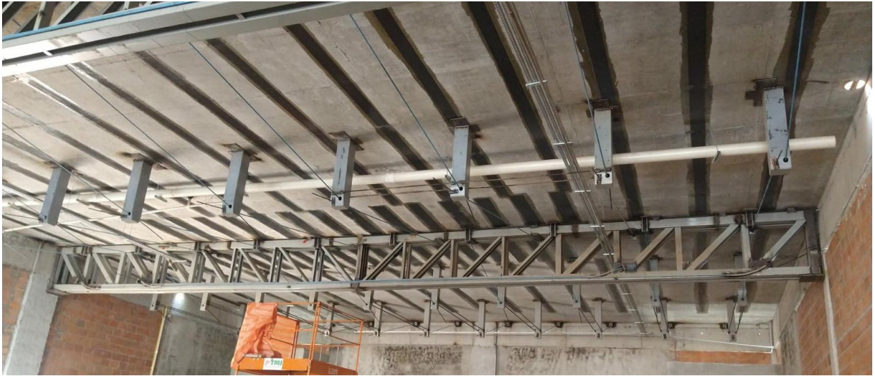
Figura 9. Protensão externa na laje de cobertura do auditório.
