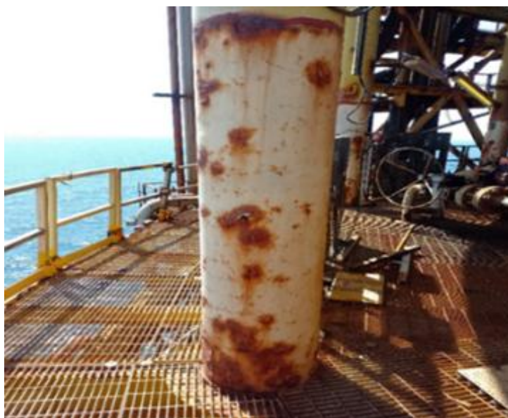
Figura 1. Corrosão alveolar.
