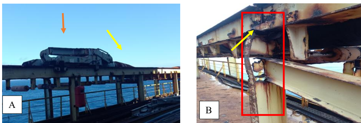
Figura 7. cripling na coluna da esteira de uma linha de offloading .
