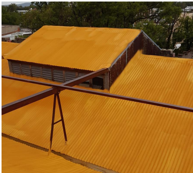
Figura 9. Foto da estrutura exterior.
