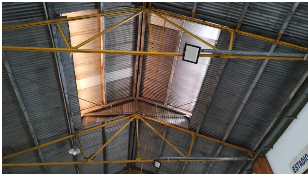
Figura 10. Foto del cordón inferior.
