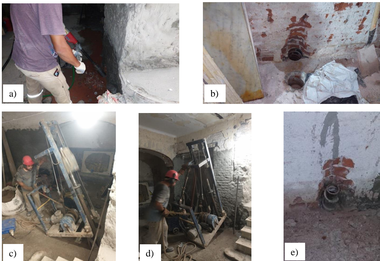
Figura 16. Detalhe do procedimento de intervenção. a) Imagem da perfuração com serra diamantada. b) Fotografia dos orifícios perfurados na alvenaria até o horizonte de deslizamento pré-existente. c) Fotografia tirada durante o processo de cravação mecânica da microestaca. d) Fotografia tirada durante a cravação de uma microestaca. e) Imagem da extremidade superior do tubo Manessmann, cravado, com estribos soldados para aumentar a superfície de atrito contra a laje de subpressão a ser executada.
