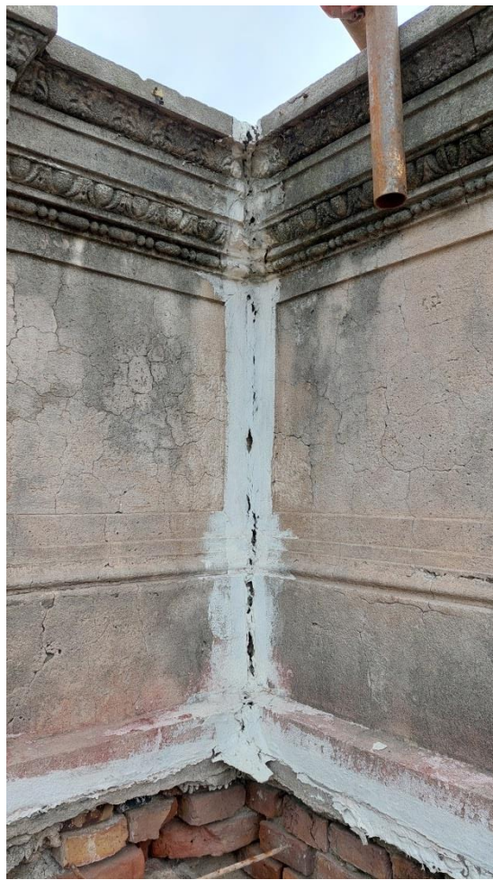
Figura 8. a) Desvinculação de muros nos encontros de esquina, devido a deslocamentos e afundamentos diferenciais entre eles. b) Detalhe do desprendimento de ornamentos e volutas devido à deformação das cornijas, como resultado dos assentamentos. Esses elementos soltos representam risco de queda.
