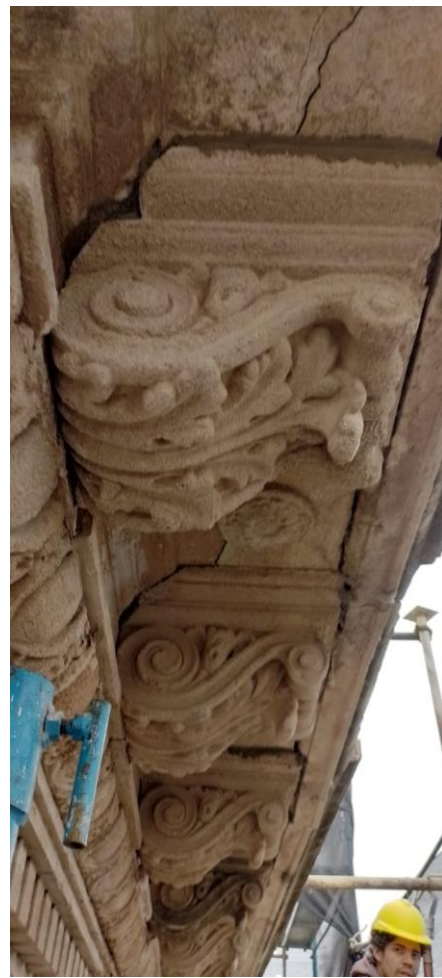
Figura 8. a) Desvinculação de muros nos encontros de esquina, devido a deslocamentos e afundamentos diferenciais entre eles. b) Detalhe do desprendimento de ornamentos e volutas devido à deformação das cornijas, como resultado dos assentamentos. Esses elementos soltos representam risco de queda.
