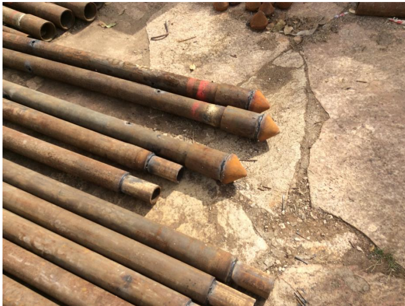
Figura 10. Detalhe dos tubos Manessmann com diâmetro de 73 mm. São visíveis o orifício para injeção e os suportes para cravação sem transmissão de vibrações ao solo circundante.
