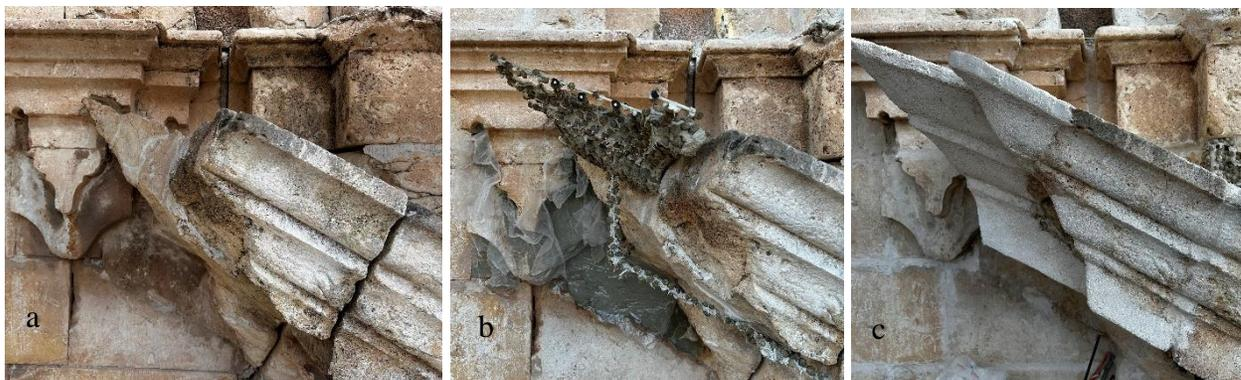
Figura 12. Vários aspectos da reintegração volumétrica utilizando argamassa com núcleo leve e argamassa leve. a) Área faltante já consolidada, aguardando perfurações para ancoragens. b) Aspecto do núcleo leve preparado para receber a aplicação da argamassa externamente. c) Aspecto com a argamassa já reintegrada, aguardando a aplicação de uma veladura com água de cal e pigmentos para harmonizar a área adicionada com o restante da fachada.
