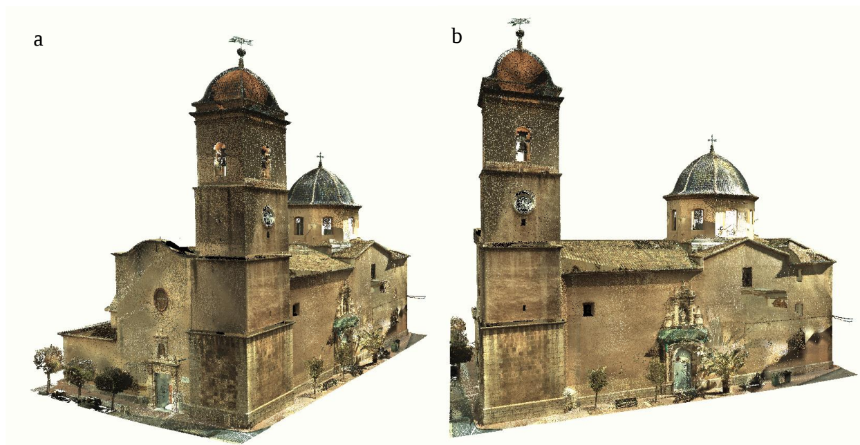
Figura 1. Fachadas principales de la iglesia obtenidas mediante levantamiento topográfico con Láser-Escáner. (a) Acceso Principal, (b) Fachada de San Pedro.
