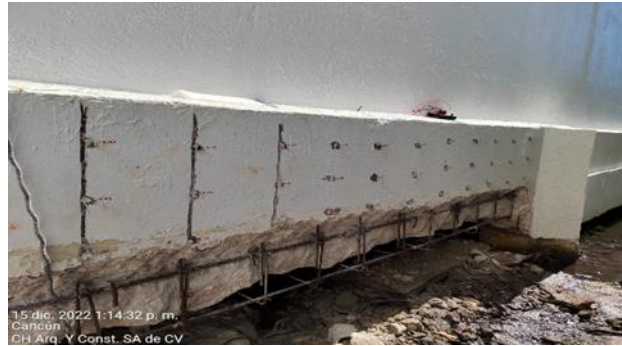
Figura 16. Instalação de ânodos no concreto com verificação de instalação em Cancún, México.
