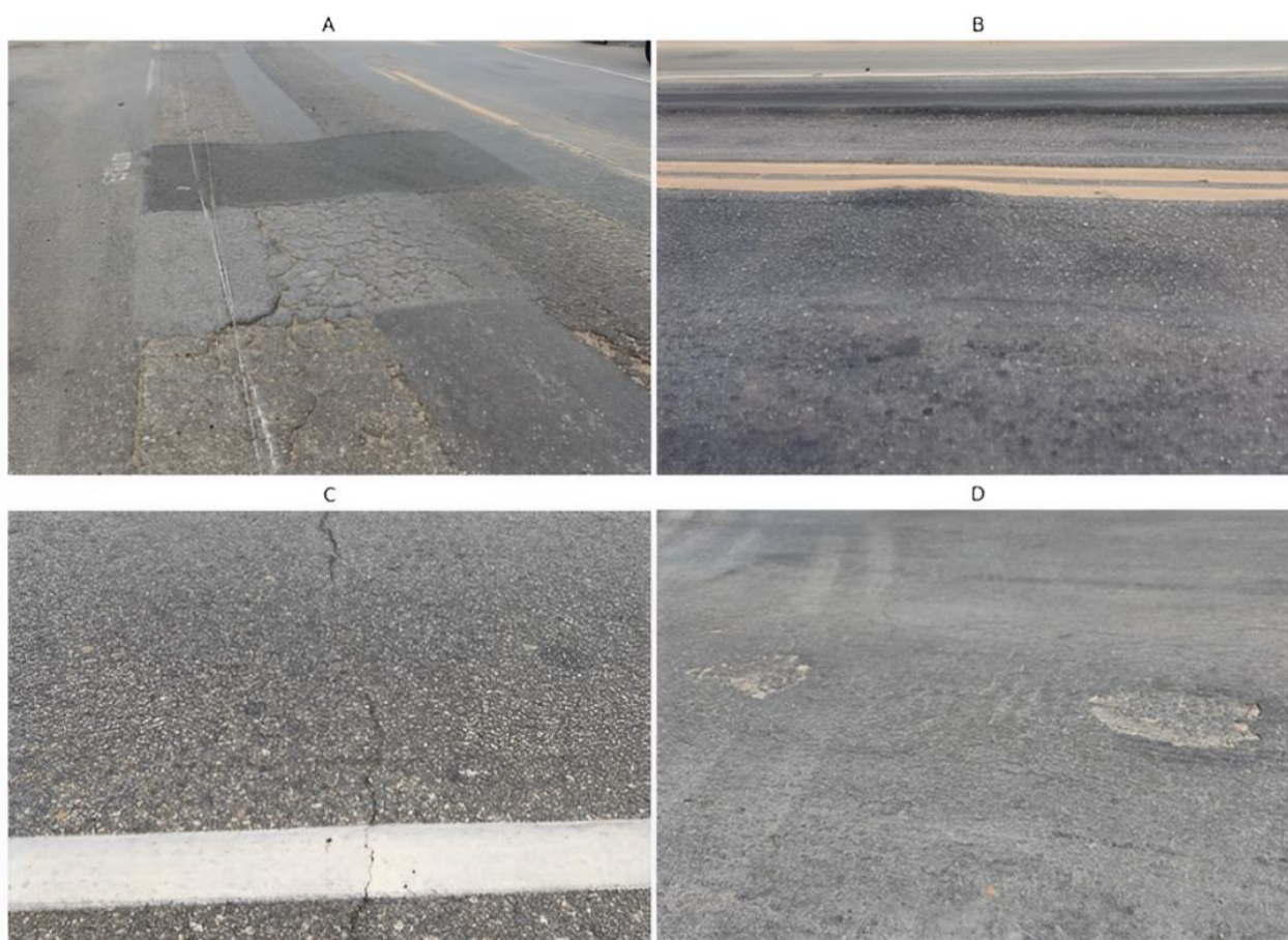
Figura 2 - Principales defectos encontrados en la BR-222: (a) parches y grietas cocodrilo (b) socavones (c) grietas transversales (d) baches y desgaste.
