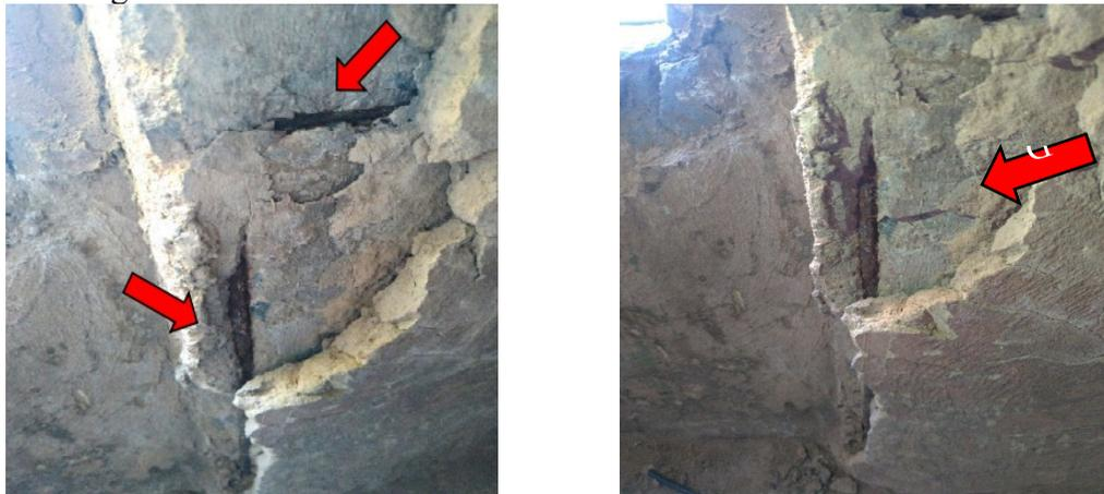
Figura 1. Desprendimiento de hormigón y corrosión de la armadura en el elemento P01
