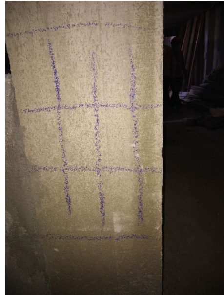
Figura 2. Área da coluna preparada para medições, marcada com giz de cera a localização das barras
