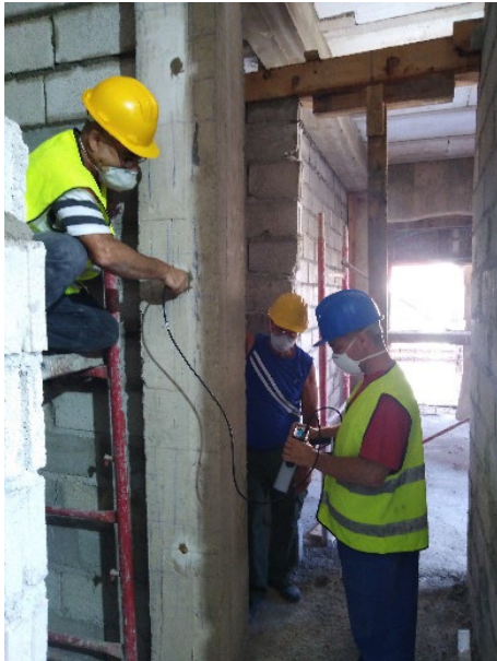
Figura 1. Realizando as medições em colunas
