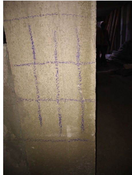
Figura 2. Área de la columna preparada para mediciones, señalizada con crayola la ubicación de las barras
