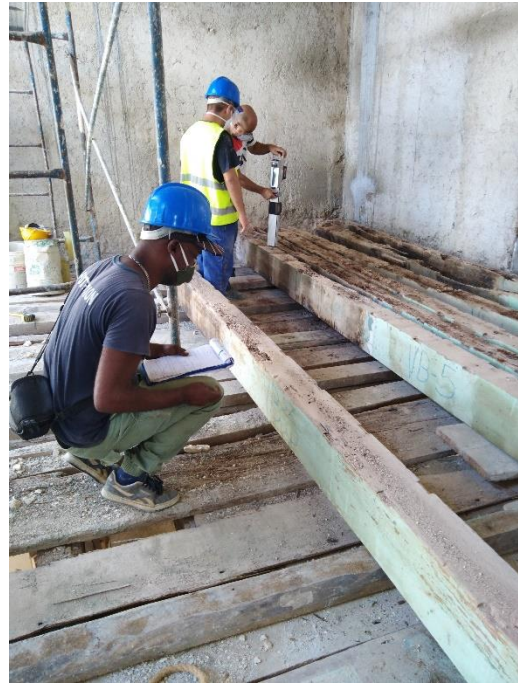
Figura 4. Inspeção e classificação visual de vigas desmontadas
