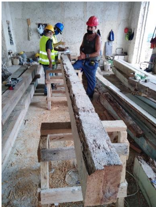
Figura 3. Etapa de inspección detallada en viga montada sobre burros de madera
