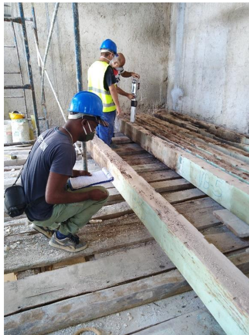
Figura 4. Inspección y clasificación visual de vigas desmontadas
