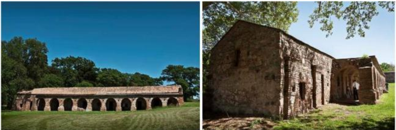
Figura 17. Vistas generales del edificio del Noviciado
