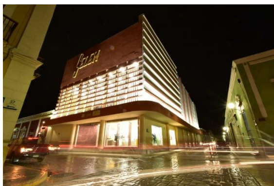
Figura 7. Vista noturna do edifício após intervenção
