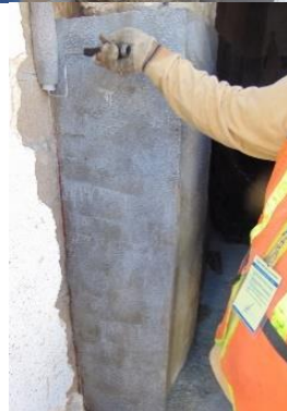
Figura. 6. Processo de reparo profundo uniforme
