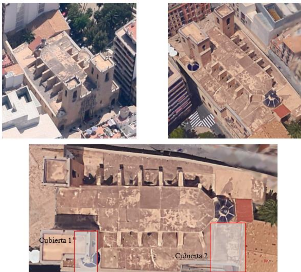
Figura 1. Vista aérea de la Basílica de Santa María. Alicante. Sup. Izq.: fachada Noroeste. Sup. Drcha.: Fachada sudeste. Inferior: Vista en planta de la Basílica de Santa María. Alicante. Identificación de cubiertas de estudio. Fuente: Imágenes ©2016 Google, Datos del mapa ©2016 Google, Inst. Geogr. Nacional.
