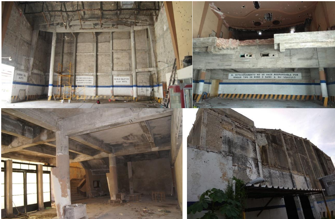
Figura 2. Estado en que se encontraba la estructura antes de ser intervenida
