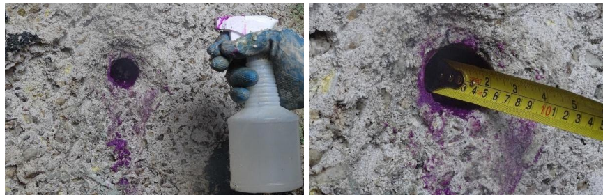
Figura 4. Muro de pozo húmedo con hormigón alcalino.
