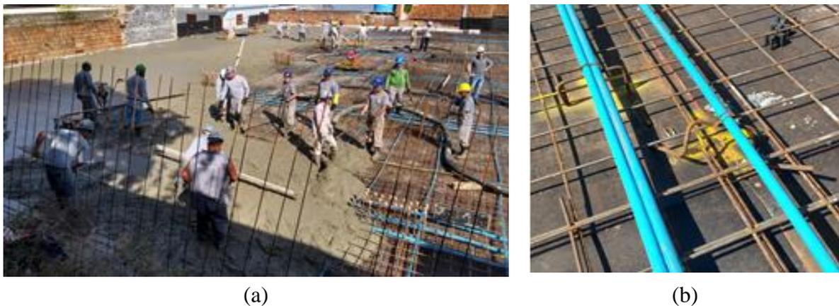
Figura 1. Operación de hormigonado: (a) Manejo de la mano de obra en contacto con la armadura. (b) Separador dañado y mal posicionado.
