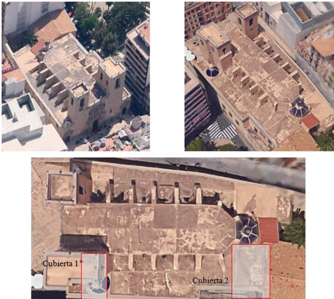
Figura 1. Vista aérea de la Basílica de Santa María. Alicante. Sup. Izq.: fachada Noroeste. Sup. Drcha.: Fachada sudeste. Inferior: Vista en planta de la Basílica de Santa María. Alicante. Identificación de cubiertas de estudio. Fuente: Imágenes ©2016 Google, Datos del mapa ©2016 Google, Inst. Geogr. Nacional.
