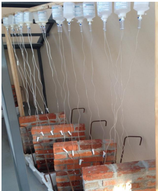
Figura 4. Aplicación de bloqueadores químicos.
