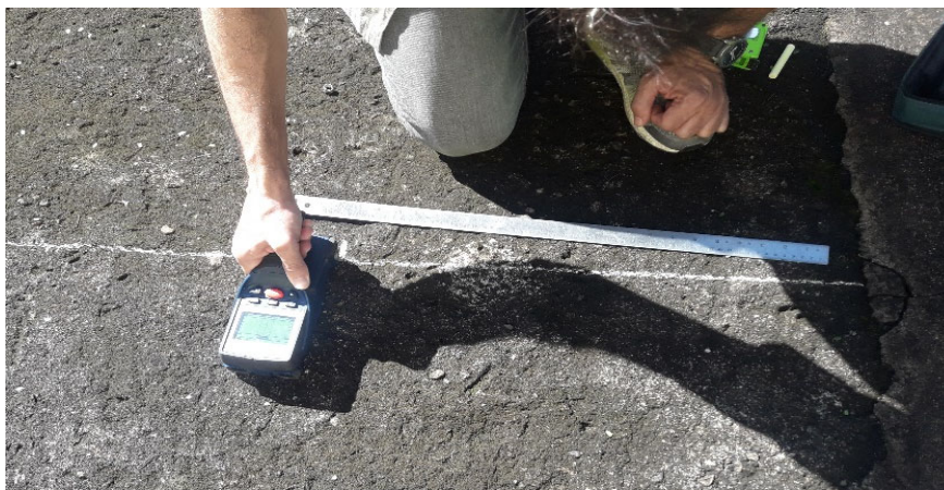
Figura 9. Execução do ensaio de pacometria
