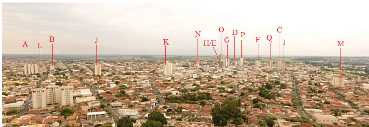
Figura 1. Edifícios estudados (vista panorâmica)
