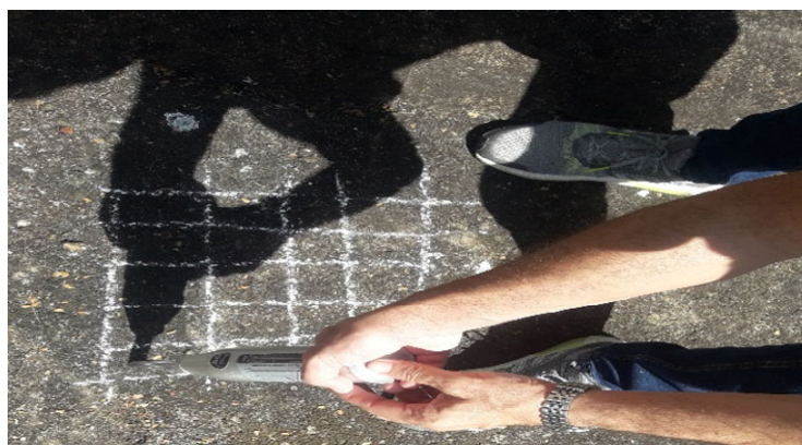
Figura 7. Ejecución de la prueba de esclerometría
