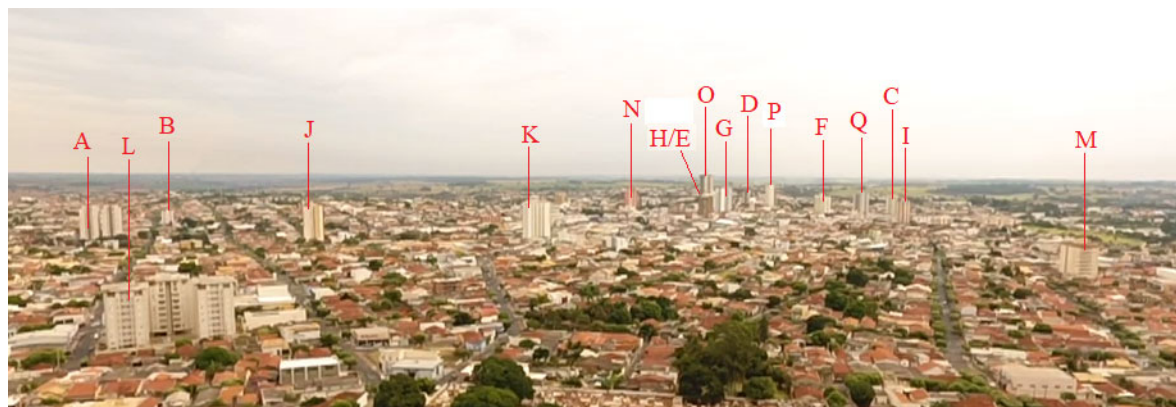
Figura 1. Edificios estudiados (vista panorámica)
