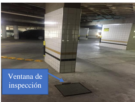
Figura 14. Ventana de inspección.
