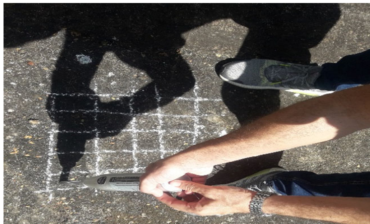
Figura 7. Execução do ensaio de esclerometria
