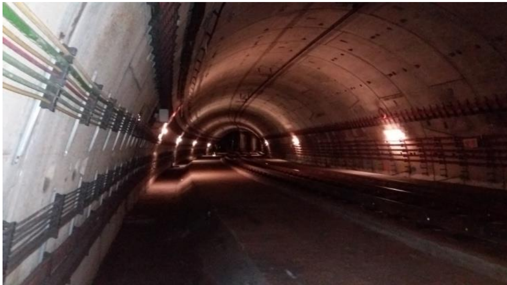
Figura 9. Vista general del túnel en la sección instrumentada.
