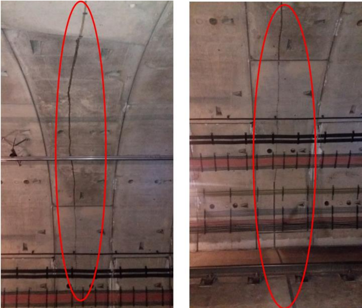
Figura 11. Procedimiento de adherencia de la fibra óptica en la losa del carril de circulación de la vía 2 y en la bóveda del túnel.
