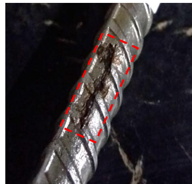
Figura 21. Perda de massa das barras de aço (L1).
