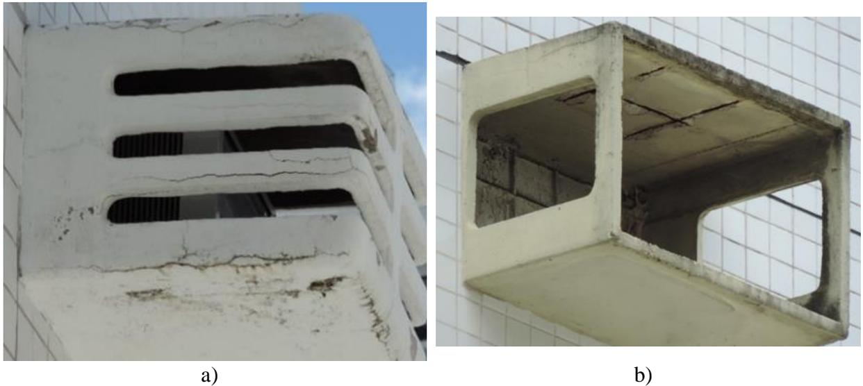
Figura 12. Corrosão da armadura em modelo tipo janela: a) fissuras; b) destacamento do concreto
