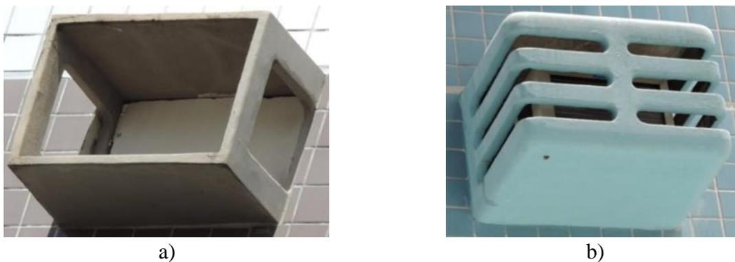
Figura 3. Suporte de concreto armado, tipo janela: a) modelo aberto; b) modelo fechado
