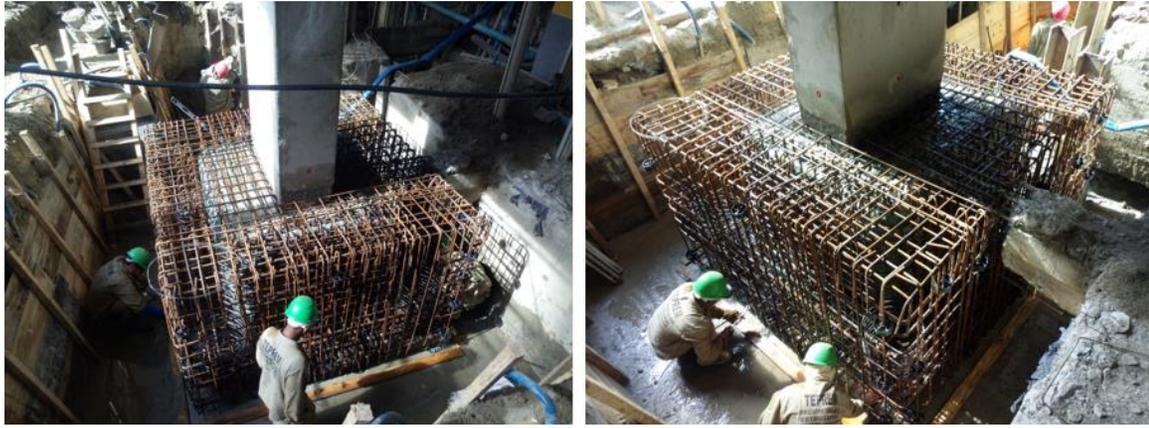
Figura 13. Detalhe da execução dos serviços de armação de reforço do bloco de fundação.
