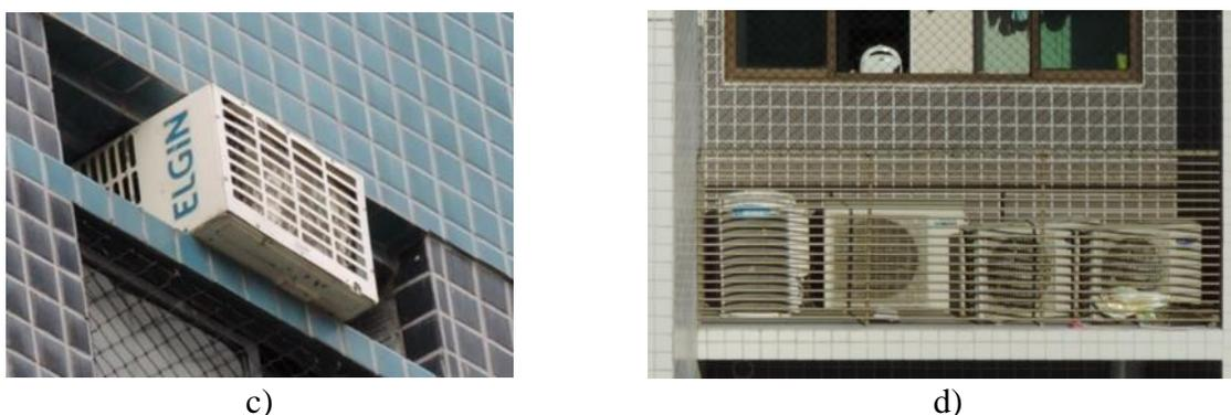
Figura 4. Outros modelos de suporte: c) modelo “oculto”; d) modelo para *split*
