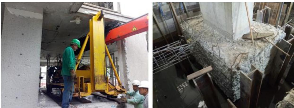
Figura 8. Detalhe da execução dos serviços de cravação (à esquerda) e das estacas metálicas cravadas no entorno do bloco de fundação a ser reforçado (à direita).
