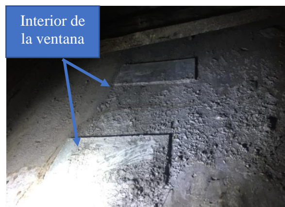
Figura 15. Interior de la ventana inspección.
