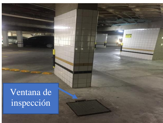
Figura 14. Ventana de inspección.
