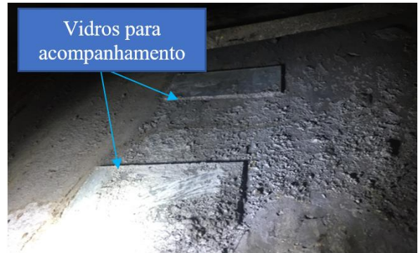
Figura 15. Interior da janela de Inspeção.
