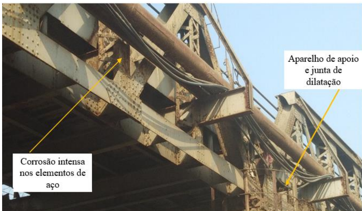
Figura 2. Foto da ponte que mostra o local do aparelho de apoio e junta de dilatação
