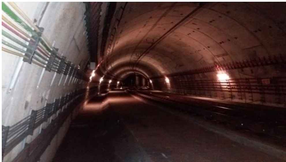
Figura 9. Vista geral do túnel na seção instrumentada.
