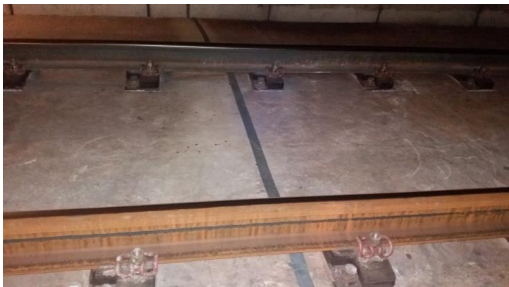
Figura 10. Fibra ótica protegida sob os trilhos do trem.
