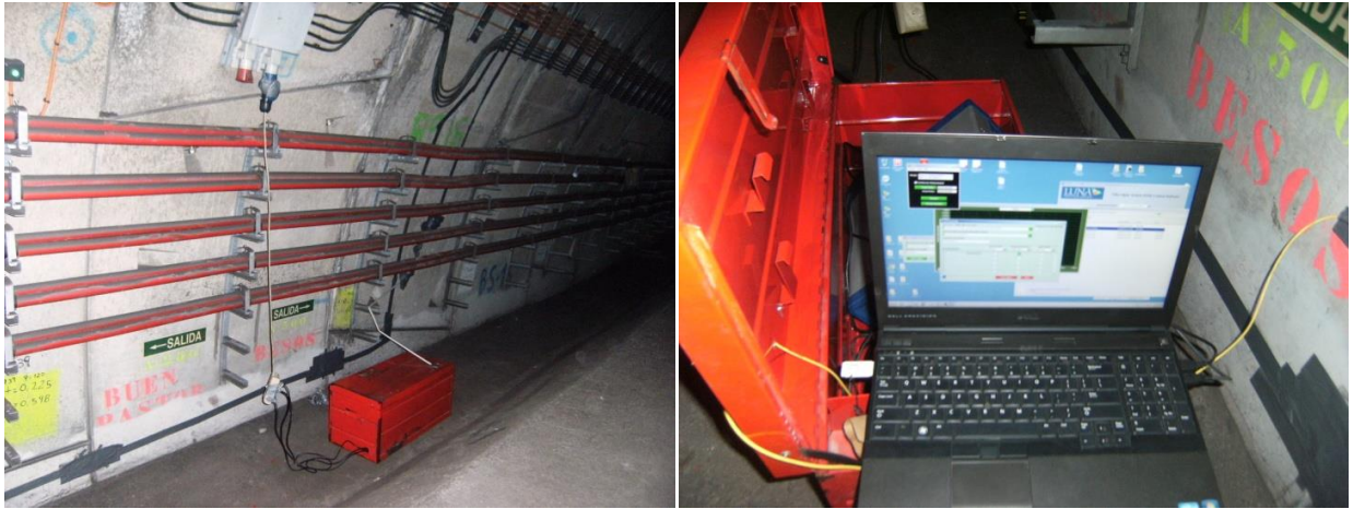
Figura 8. Carrete de fibra óptica restante sujeto a la estructura y ODiSI (Optical Distributed Sensor Interrogator, de LUNA Technologies, Model A50) en funcionamiento.
