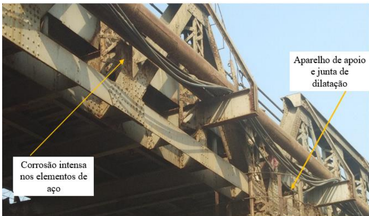
Figura 2. Foto da ponte que mostra o local do aparelho de apoio e junta de dilatação
