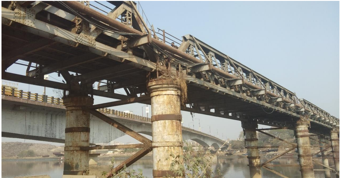
Figura 3. Foto da ponte que mostra o tipo estrutura metálica.
