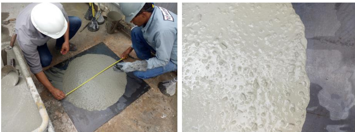
Figura 15. Aspecto visual del concreto auto compactante utilizado en el refuerzo de los encepados estructurales.
