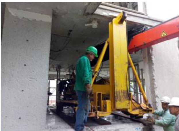
Figura 8. Detalle de la ejecución de los trabajos de conducción (a la izquierda) y de los pilotes metálicos clavados en el entorno del bloque de cimentación a ser reforzado (a la derecha).
