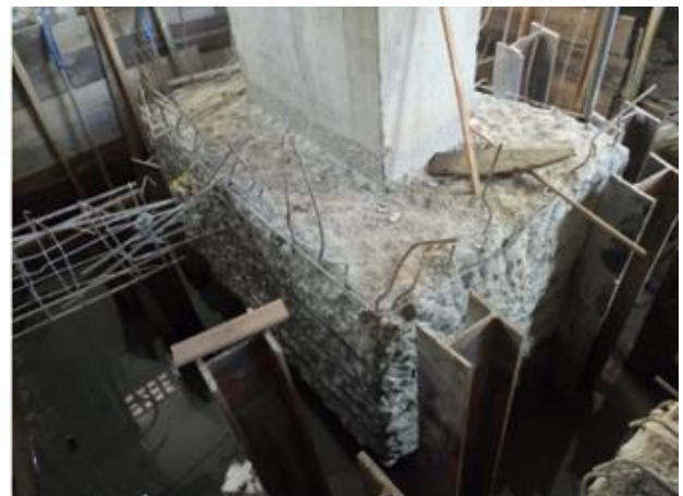
Figura 8. Detalle de la ejecución de los trabajos de conducción (a la izquierda) y de los pilotes metálicos clavados en el entorno del bloque de cimentación a ser reforzado (a la derecha).
