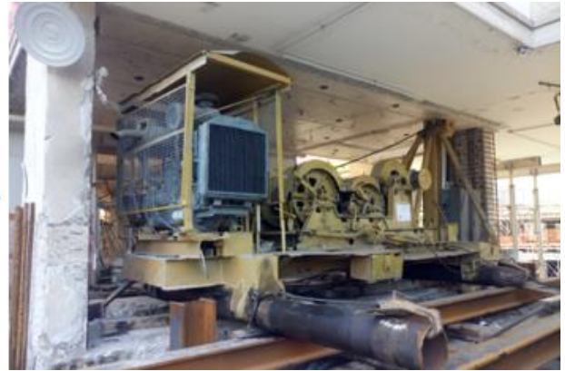
Figura 7. Detalle del martinete adaptado posicionado entre losas para realizar los servicios de hincado de pilotes de refuerzo estructural.
