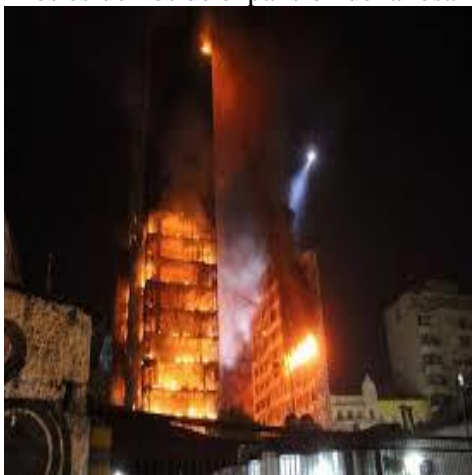
Figura 5 - Edifício Wilton Paes de Almeida sometido a incendio en 01/05/2018
