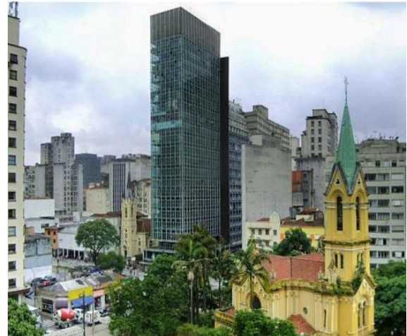
Figura 4 - Edifício Wilton Paes de Almeida, situado en el centro de Sao Paulo
