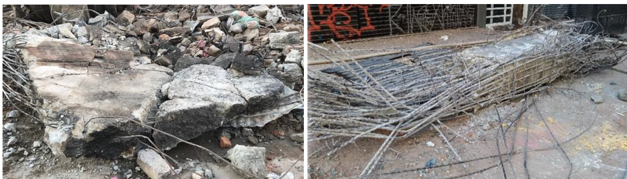
Figura 10. Secciones de losa en voladizo y columnas/pilares recogidos de los escombros para los ensayos (fuente: colección personal de Paulo Helene)
