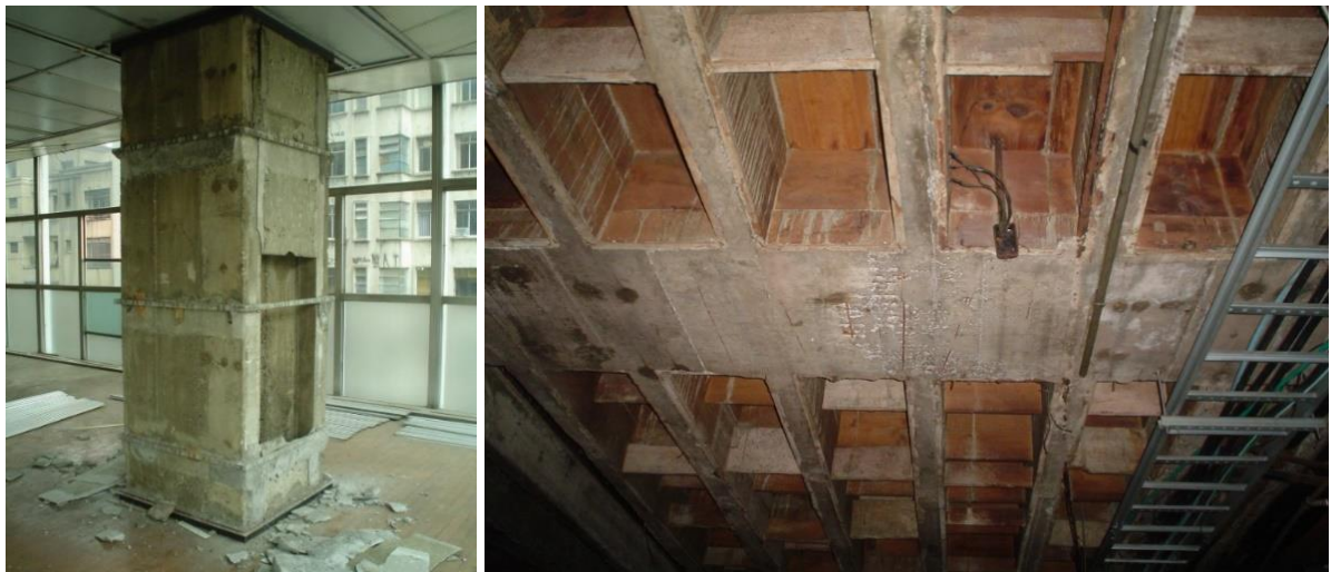
Figura 6. Columna de hormigón, donde se puede ver la "H", que en realidad es un hueco para aire acondicionado y la losa y vigas. (fuente: colección personal de Leandro Coelho)
